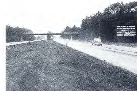
4.2 Aanleg A28 met viaduct Lhenbroekoverweg (1971)
