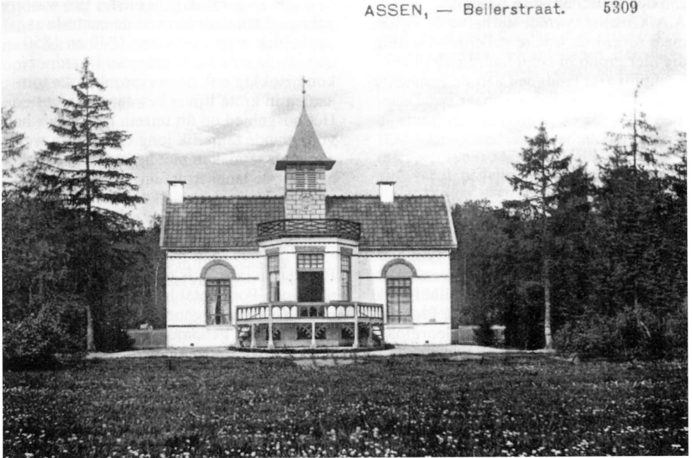
Het landhuis 'De Eerste Steen', gebouwd in 1907 door H.J. Oosting (1842-1915), op een Ansichtkaart uit het begin van deze eeuw (collectie Gemeentearchief Assen)
